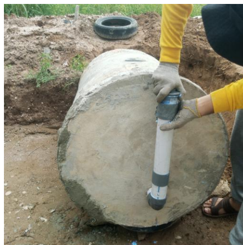
Gambar 4. Proses Konstruksi Biodigester
